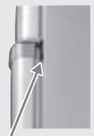
密封襯條處發生有縫隙的狀態
